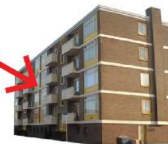
appartementen 1980 licht geïsoleerd behoefte 70 graden
