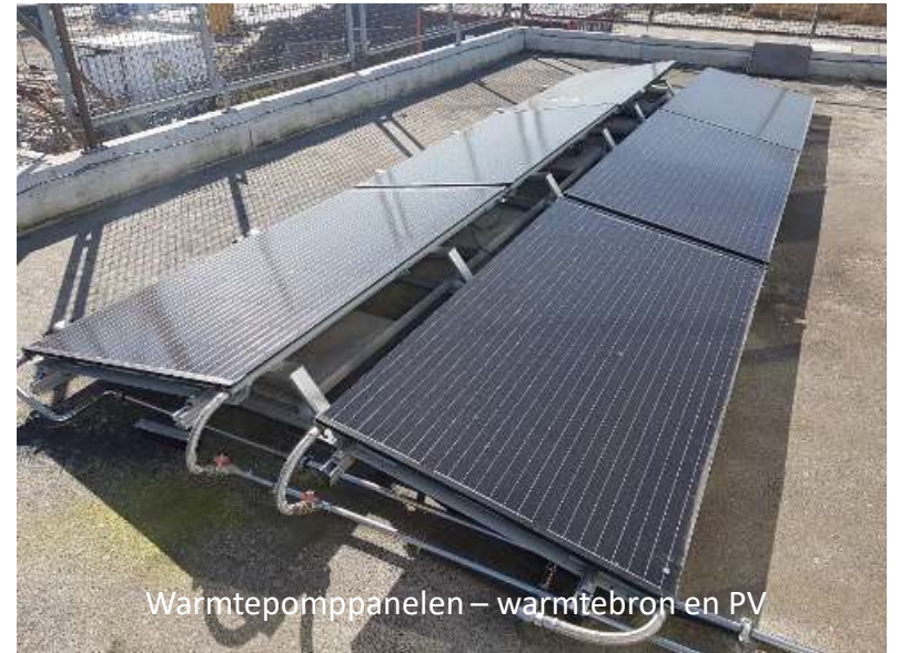
Centrale warmtepompen op het dak
