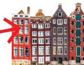
monumentale woningen niet geïsoleerd behoefte 90 graden
