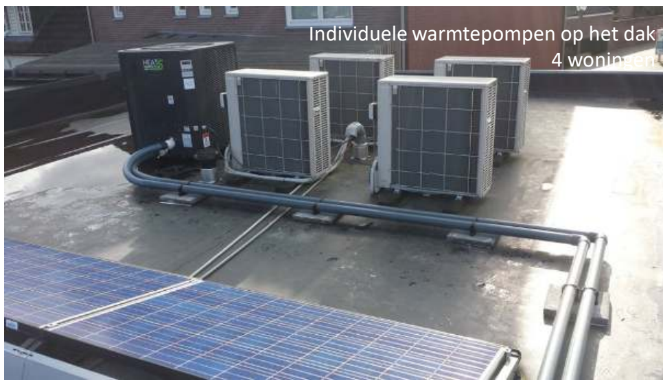
Warmtepomppanelen – warmtebron en PV
