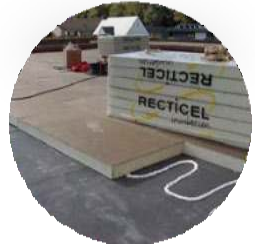
dakisolatie op alle daken met PIR platen Rc = 6,5 (eis NEF en RVO)
