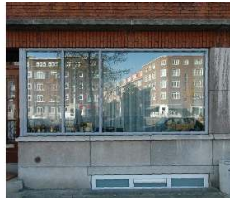
klein deel 2015 vervangen voor aluminium kozijnen met HR++ Uw = 1,5
