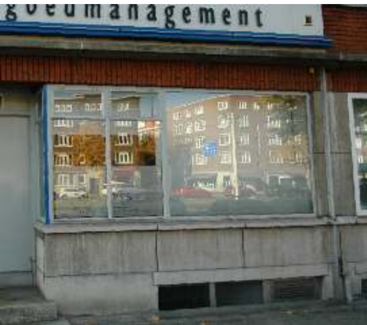
Oorspronkelijk staal met enkelglas Uw = 5,6 (isoleert niet)
