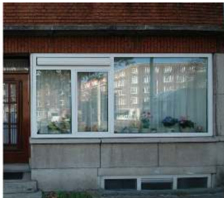
Groot deel 1985 vervangen voor aluminium kozijnen met dubbelglas Uw = 3
