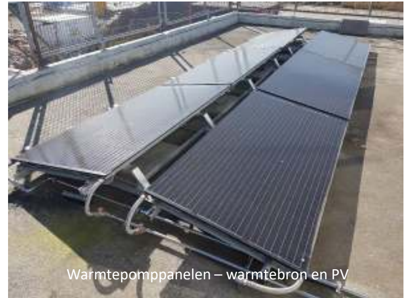
Centrale warmtepompen op het dak
